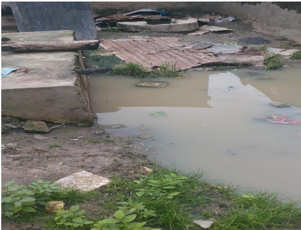
Figure 8. Photographie illustrant le risque de mélange des eaux de pluies avec les eaux vannes dans la fosse (prise de vue : Aissi, mars 2023)
